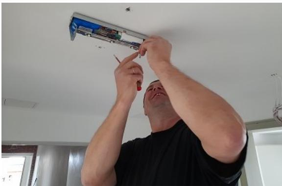
Unsere Baustelle befindet sich im Endspurt. Die Elektriker basteln weiter an der Brandschutzbeleuchtung, die mit eigenem Stromkreislauf bei Dunkelheit die Fluchtwege markiert.
