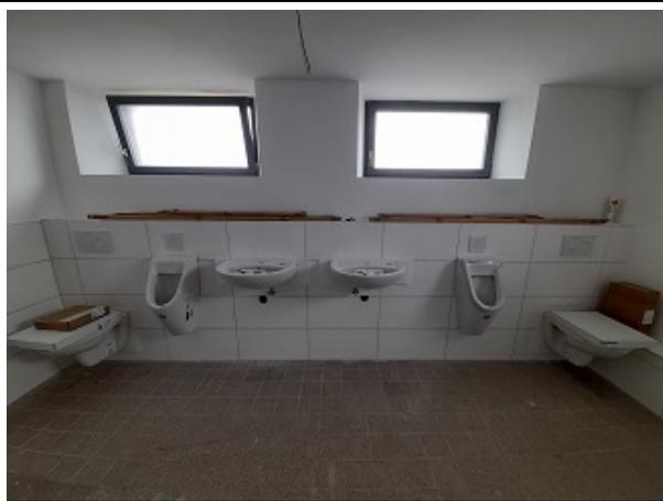
Hier ein Blick in die Gemeinschaftstoiletten mit den beiden Herrenkabinen, von denen noch die Trennwände fehlen. Rechts und links nahe den Wänden zwei Toiletten, auf denen die noch verpackten Klobrillen liegen. Daneben die Urinale und in der Mitte die Waschbecken, an denen die Anschlüsse noch angebracht werden müssen.
