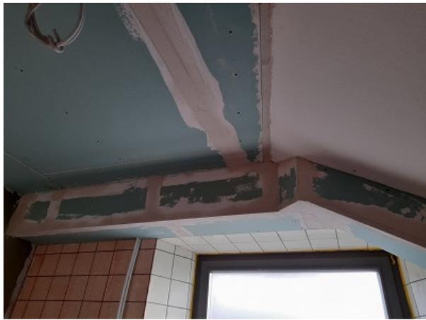
Hier sind nun Decke und Rahmen mit Gipskarton bestückt, die Ritzen wurden zugespachtelt. „Kunst am Bau“, kommentiert der Architekt halb spöttisch, halb anerkennend die komplizierte Abkofferung der Handwerker in diesem Duschaum.
