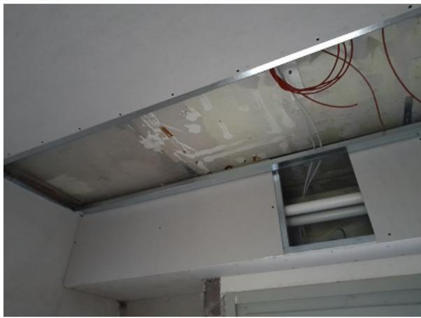
In diesem Flur mit dem Notausgang sind nun Abkofferung und Decke nahezu fertig. Oberhalb der neuen Decke verlaufen die Stromleitungen.
