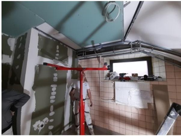
Hier werden nun mithilfe dieses roten Hubgestells die Gipskartonplatten unter die Decke gehoben und an die metallenen Rahmen geschraubt.
