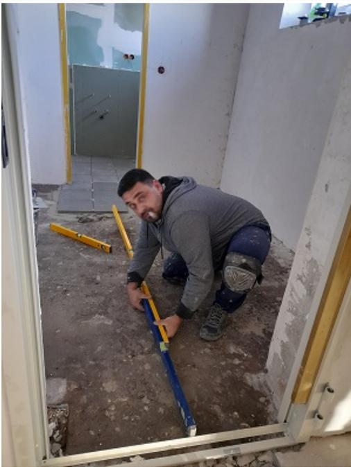
Im Untergeschoss beginnt ein neuer Abschnitt: Fliesen werden gelegt. Dies ist eines der Referenzzimmer; im Hintergrund ist das Bad zu sehen mit der Abkofferung des Waschbeckens. Die grauen Bodenfliesen wurden bereits im Bad verlegt und schließen sich im Raum an.
