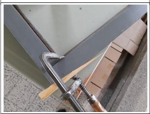
Die beschädigten Stellen werden an beiden Seiten sauber abgesägt und durch einen Keil ersetzt. Dieser wird angeklebt und mit einer Schraubzwinge gehalten, bis der Holzleim fest ist.
