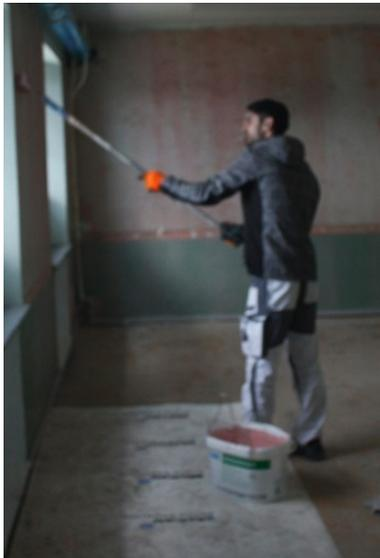
... während in demselben Raum nebenan die Grundierung für den Putz auf die Wände aufgetragen wird.
