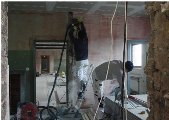
Und an der Hinterwand werden die Schlitz für die dazugehörige Elektrolitze in den Putz gefräst. Ein Höllenlärm!
