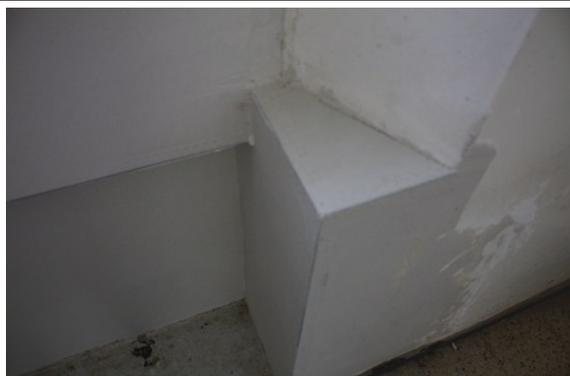
... und anschließend feingedübelt. Hier ist der Feinputz noch feucht. Bis zum nächsten Bericht ist er wahrscheinlich getrocknet.
