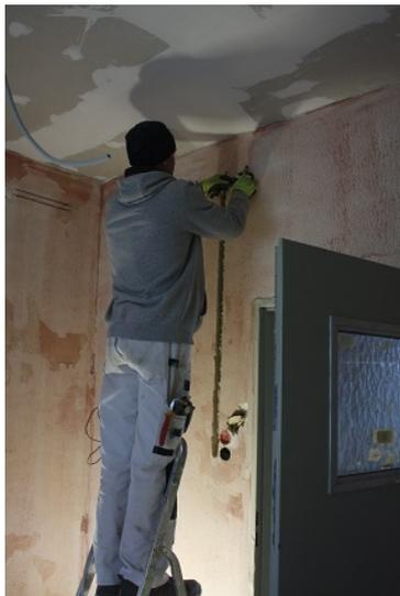
Unterdessen geht auch der Innenausbau weiter. Bevor in den Gästezimmern der oberen Etage die Wände weiter verputzt werden können, müssen noch ein paar verbliebene Stromlitzen verlegt werden.
