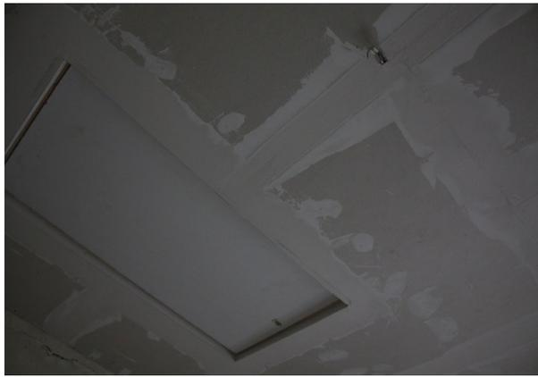
So sieht der geglättete Gipskarton im Treppenraum vor der Westkanzel aus: Nähte und Schraubvertiefungen sowie die Übergänge zum Rahmen der herunterklappbaren Speichertreppe wurden angeglichen.
