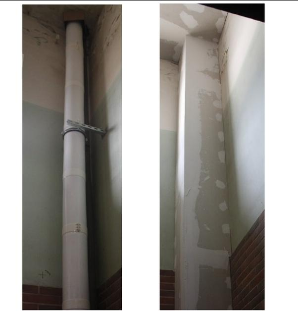
Das dicke weiße Abzugsrohr der Gastherme und eine dahinterliegende Heizungsleitung im Treppenraum vor der Westkanzel werden ebenfalls mit Gipskarton verkleidet und feingeputzt. ‚Abkoffern‘ nennt man das.
