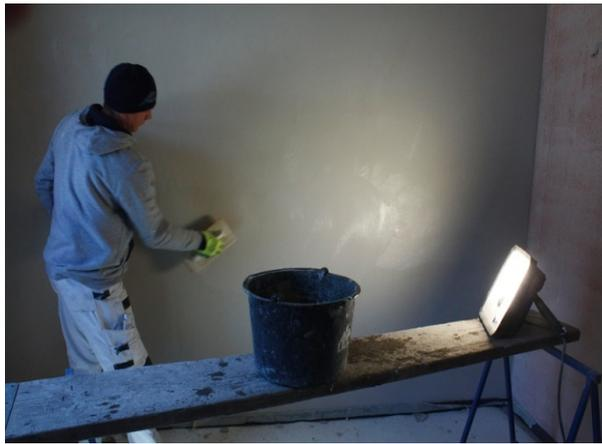
Hier sehen wir nun, wozu die rote Grundierung dient: damit der Putz an den Wänden hält, mit dem der Meister der Glättekelde die Wände der Gästezimmer in der oberen Etage auskleidet.
