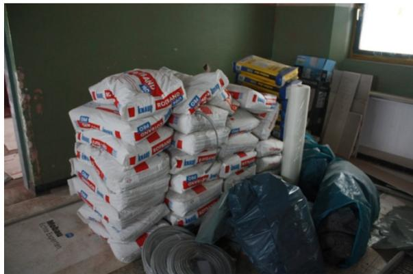
Innen arbeitet unser rumänisches Team an den Decken und Wänden weiter. Zunächst ist nur die obere Etage dran; in der unteren sind noch die Installateur\*innen zugange, und später wird getauscht. Die Gipskartonverkleidung der Decken erfordert eine Glättung der Nähte und der Schraubvertiefungen. Dazu wird Feinputz verwendet – aufgrund der Größe des Hauses in nicht unerheblicher Menge.
