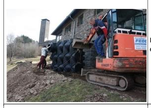
Der erste Tank wird hochkant gestellt und mithilfe eines kleinen Baggers über die Grube gezogen...
