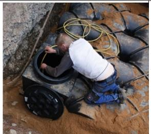
Mit dem Spülwasser werden nun gleichzeitig erstmalig die Tanks befüllt, damit sich das Sandbett unter dem Tank verdichtet und nicht später noch einmal nachgibt. Hier prüft Herr Schiffer den steigenden Wasserspiegel.
