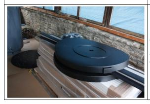
Hier die Deckel der Pufferspeicher, die obendrauf gelegt werden, nachdem die Dämmschicht angebracht wurde. Untendrunter, in Weiß, Teile der Gastherme, die in Kürze zusammengebaut wird. Das Thema "Heizung" kommt dann ausführlicher in der nächsten Fotostory.
