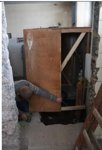
Damit die Wasseruhr, durch die ja dann Wasser strömt, in diesem ungeheizten Gebäude bei Frost nicht platzt, wurde eine isolierte Holzkiste darum herum gebaut, in die ein Frostwächter, ein kleiner elektrischer Heizkörper, platziert wurde. Dieser springt ab  $0^{\circ}\text{C}$  Lufttemperatur an und verhindert das Einfrieren der Wasserleitung. Solange die Heizung noch nicht gebaut ist, muss der Wasseranschluss auf diese Weise geschützt werden.
