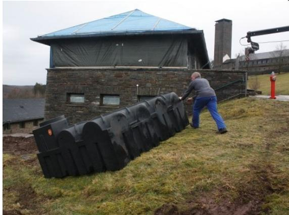
Die Tanks sind leicht genug, dass sie von 1 Person verschoben werden können. Links schiebt der Fahrer den Tank ein Stück weit den Hang hinab, damit Platz für den vierten Tank entsteht.
